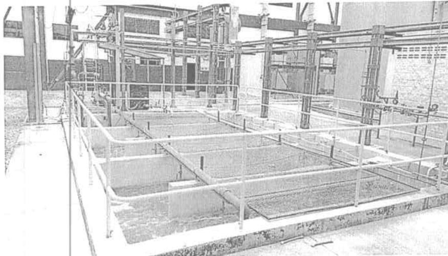
Fotografía No. 2 Pileta de neutralización, planta EDOSPINA -TEBSA
